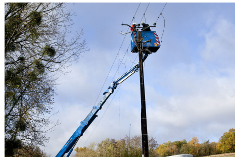
Chantier de rénovation programmée
