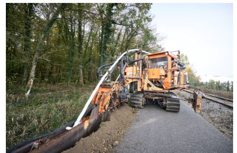
Enfouissement de ligne HTA
