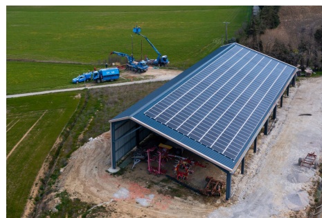
Raccordement d'une installation de production sur bâtiment agricole
