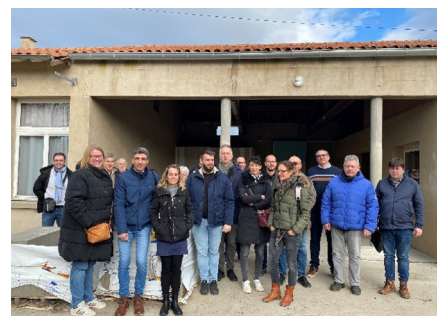
Chantier de rénovation de l'école de St-Georges-sur-Allier
